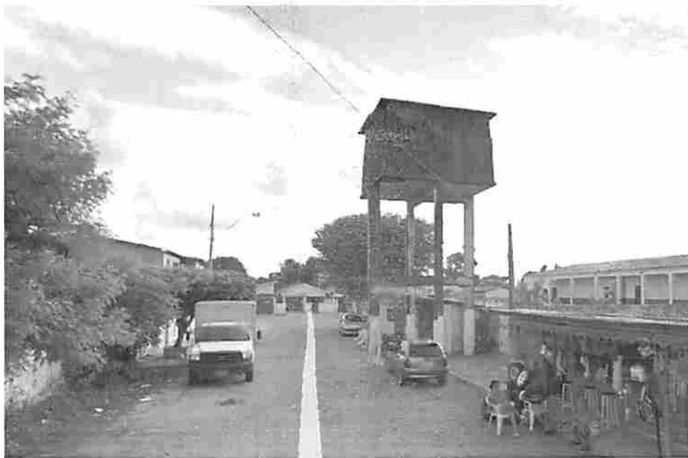
FOTO 03- CAIXA D'ÁGUA A SER DEMOLIDA
